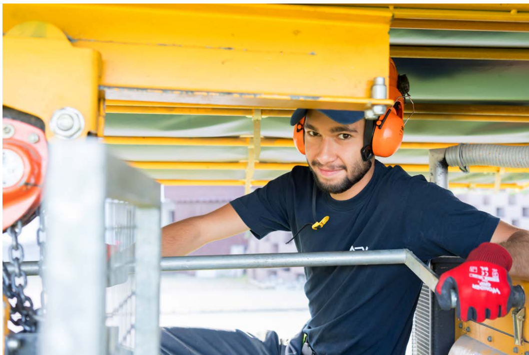
AEW Spezialist beim anspruchsvollen Kabelzug im Wiggertal
