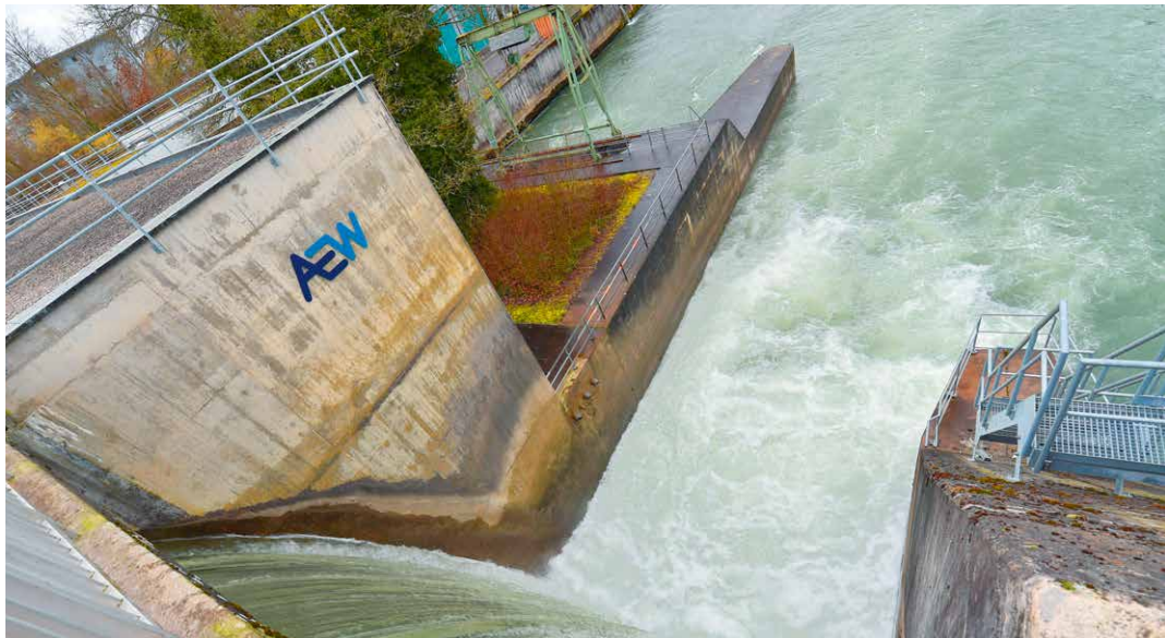
Das Wasserkraftwerk Bremgarten-Zufikon
