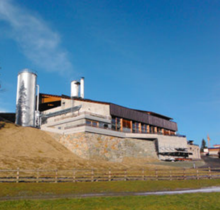
Die Besichtigung des Fernheizwerks Ritten steht ebenfalls auf dem Programm.
