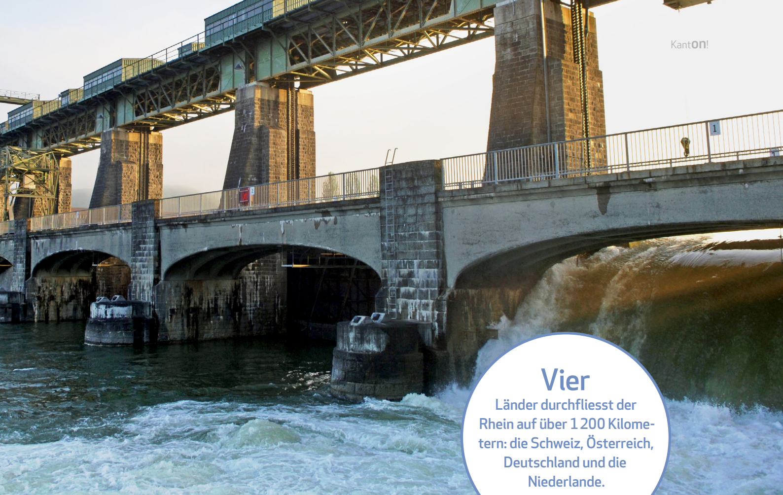
Das Stauwehr mit 212 Metern Länge verbindet die beiden Kraftwerke Augst und Wyhlen quer über den Rhein.
