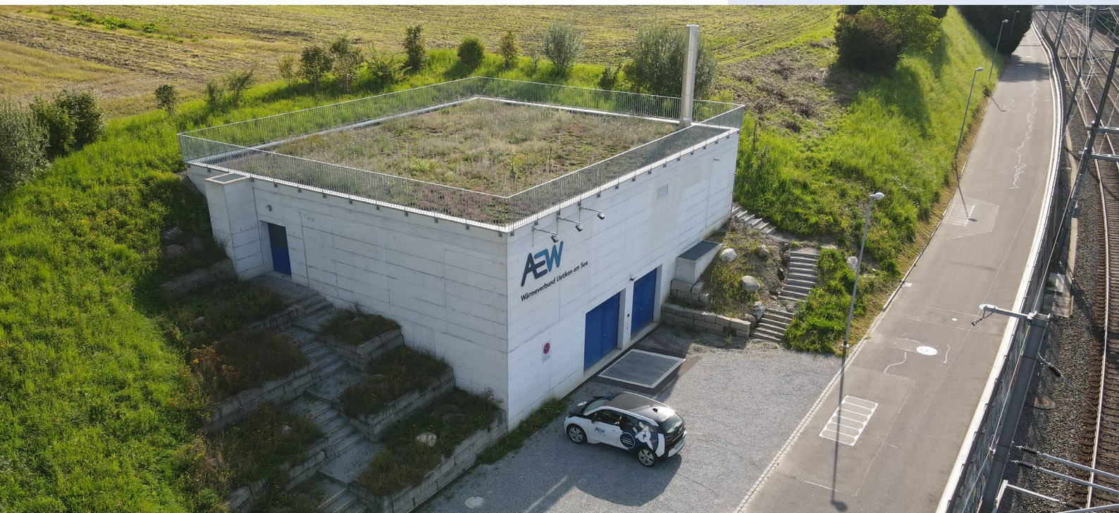
Die Heizzentrale in Uetikon am See
