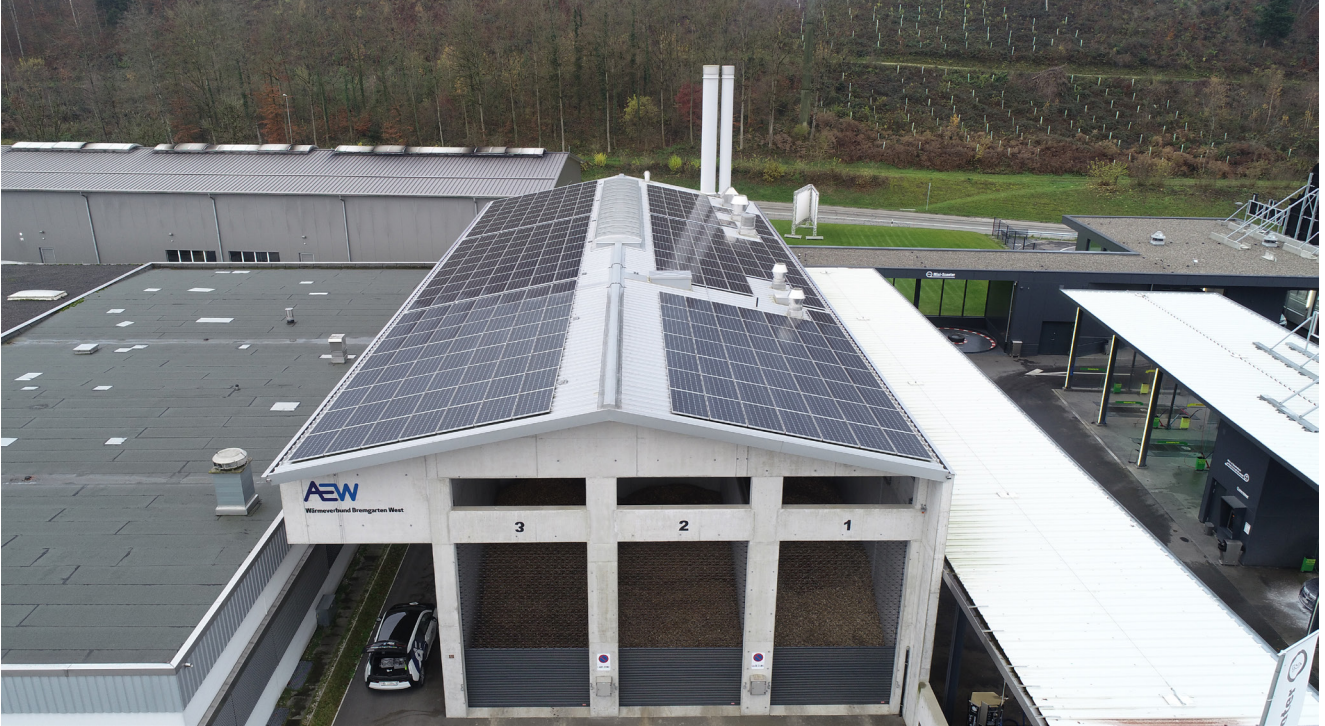
Die Wärmehaus Bremgarten West mit Photovoltaik-Anlage
