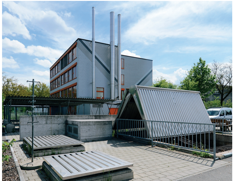
Der Eingang zur Wärmehaus im Schulhaus Isenlauf, rechts im Bild ist das Schnitzelsilo zu sehen
